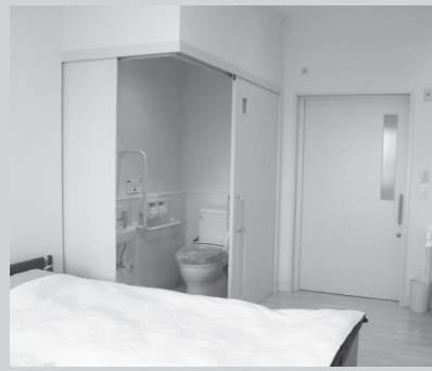
写真4 体が不自由になり、壁を引き込んだ状態
