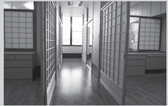
写真 可動式建具で仕切られた4人部屋(既存特養4人部屋を改修した例)
