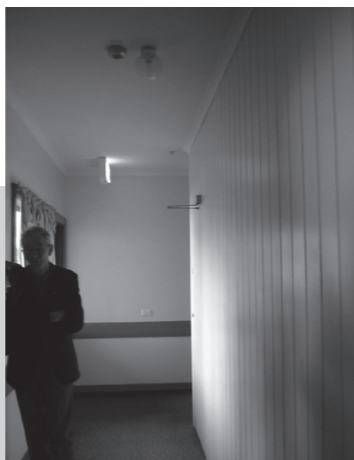
写真1 取手のないドア。ドアチェックが見えている
