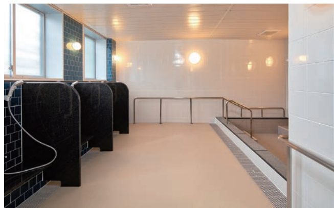
男性閉鎖病棟大浴場 隣を気にせず使用できるよう、一人ずつの隔て壁を設置
